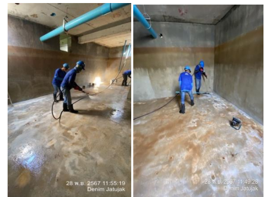
รูปที่ 2-52 การล้างถังเก็บน้ำ ประจำปี 2567
