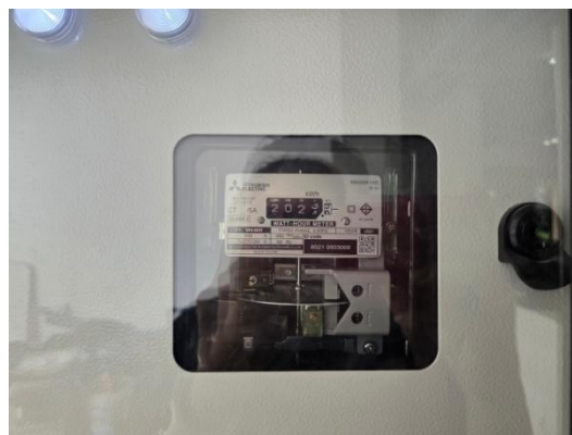
รูปที่ 2-31 จัดให้มีระบบมิเตอร์ไฟฟ้าสำหรับระบบบำบัดน้ำเสีย
