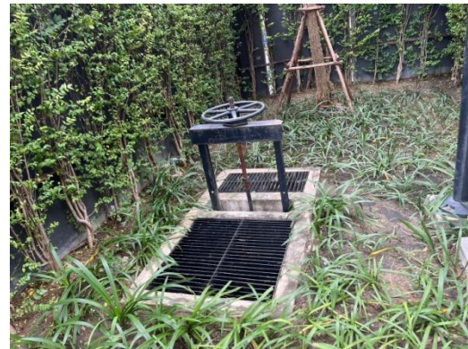
รูปที่ 2-55 ติดตั้งตะแกรงดักขยะก่อนระบายน้ำออกจาก โครงการ
