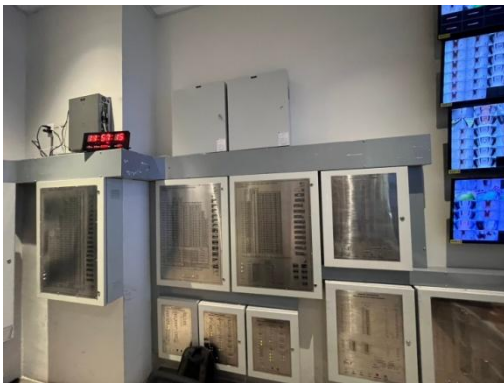
แผงควบคุม Fire Alarm
