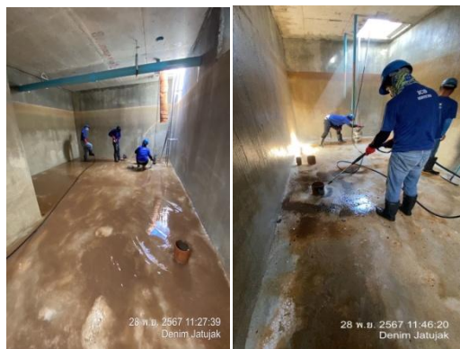
รูปที่ 2-52 การล้างถังเก็บน้ำ ประจำปี 2567
