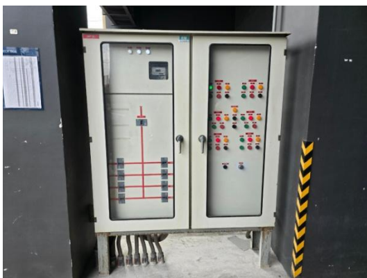
รูปที่ 2-30 ตู้ควบคุม ดูแลระบบบำบัดน้ำเสีย
